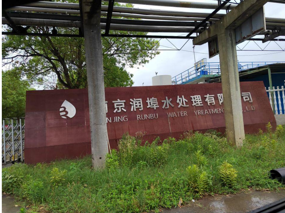
润埠污水处理站门口照片
