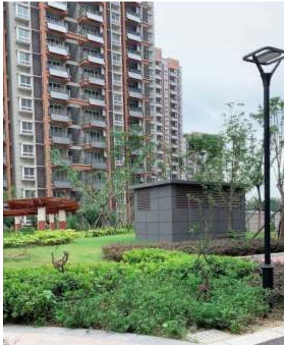
地下车库排风口
